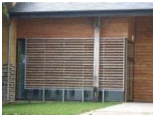
Exemple de brise-soleil en auvent
