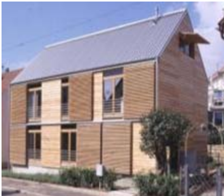
Façade-pignon aveugle contrôlant les vis-à-vis
