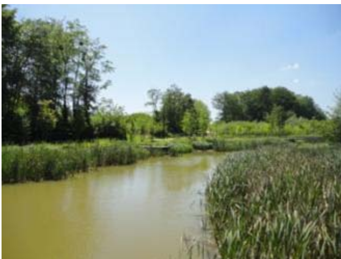
Bassin de rétention - Les Brichères – Auxerre (89)
