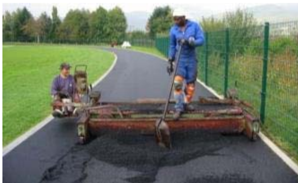
Chaussée en pneus recyclés
