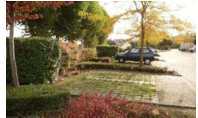
Parking sur dalles engazonnées – Combleux (45)
