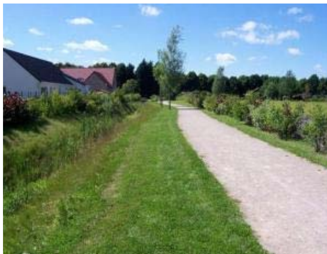
Noue paysagère - ZAC Garenne – Arques (62)
