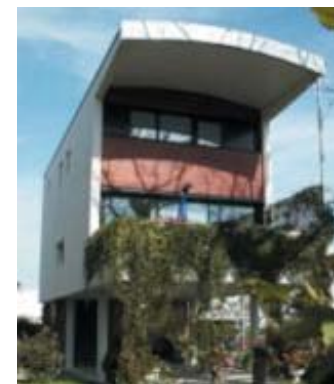
Façade sud bénéficiant d'une grande ouverture
