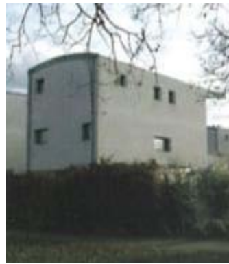
Façade arrière aux ouvertures minimum
