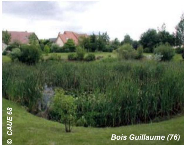
Rétention des eaux pluviales par un aménagement urbain submersible
